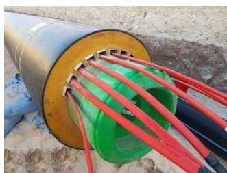
شکل ۱: نمونه‌هایی از کاربرد کابل‌های ردیاب حرارتی خود تنظیم [۷]
